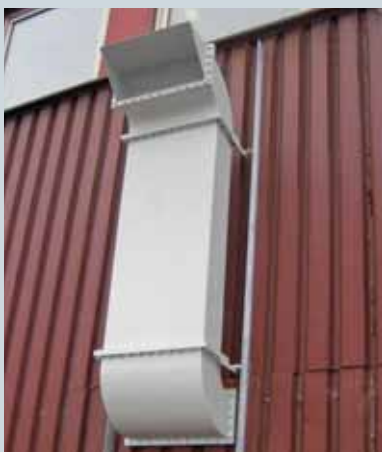
示例: 配电室外侧的通风装置
